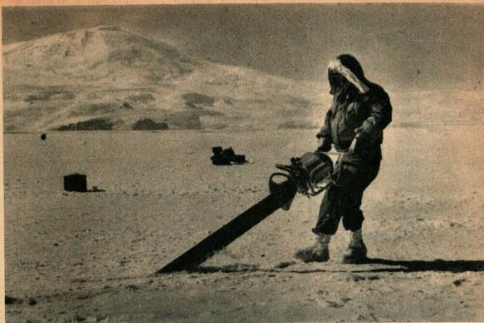
Sondage de la glace formant la piste d'envol de Mac Murdo avec une scie portative à moteur, de 2 mètres.
