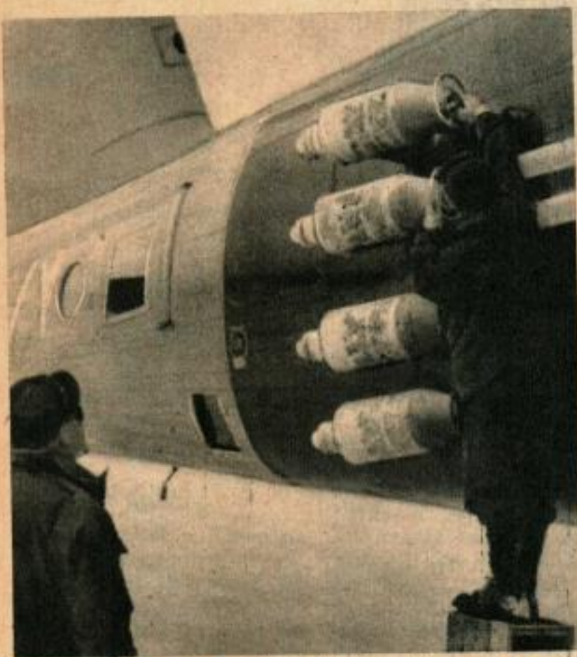
Les décollages auraient été impossibles pour les gros appareils sans les fusées de décollage «jato». Quatre fusées étaient montées de chaque côté de l'avion.
