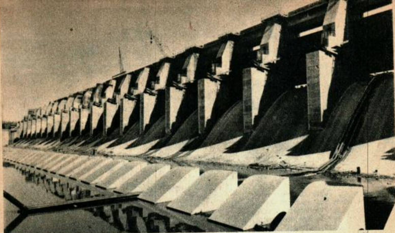
Le déversoir du barrage de Dalles est presque terminé. La retenue d'eau remontera sur 40 km, recouvrant d'eau plus de 4 000 hectares.
