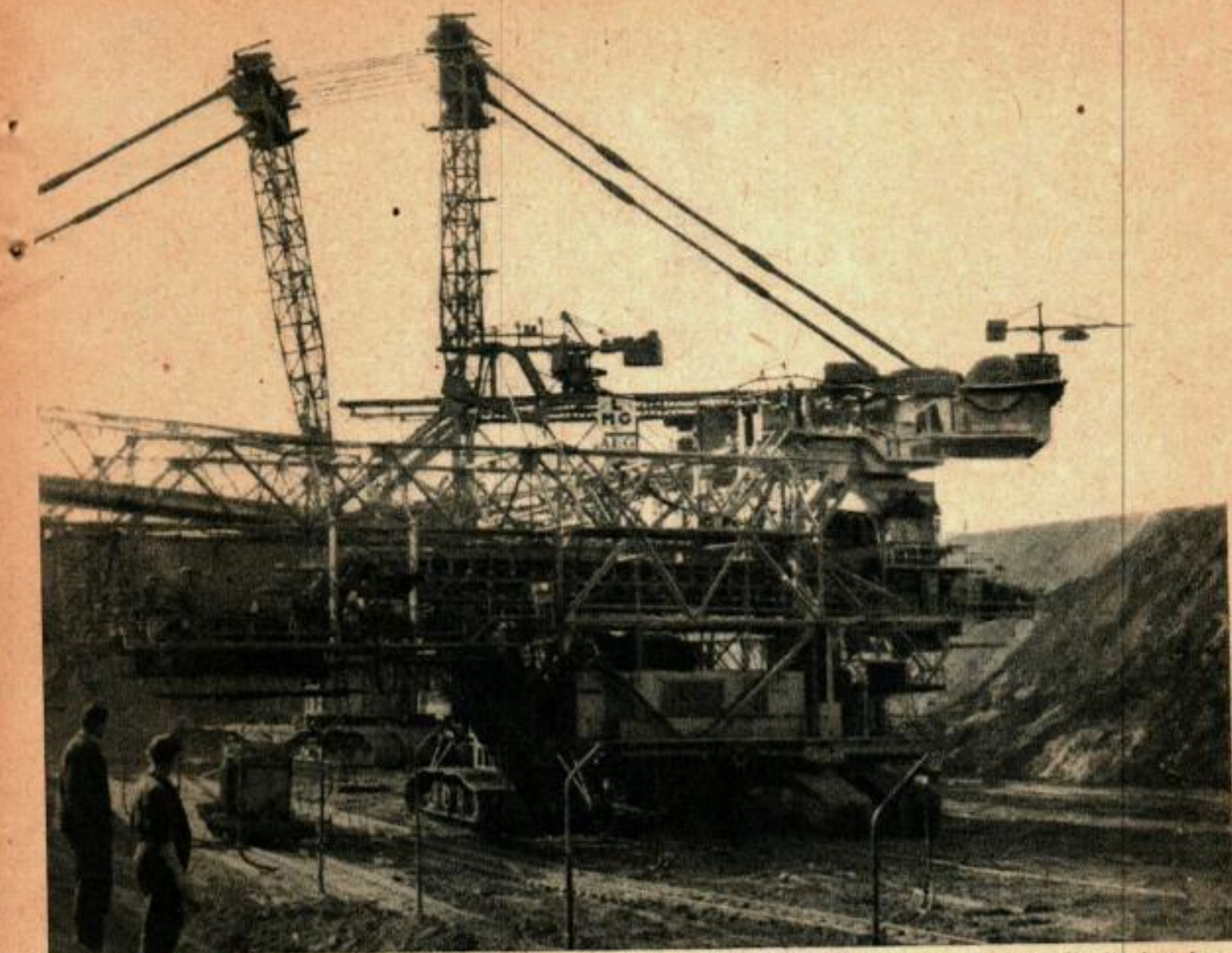
La drague géante se déplace sur 18 groupes de chenilles. La courroie transporteuse déverse le lignite dans les wagons qui passent sous la machine.
