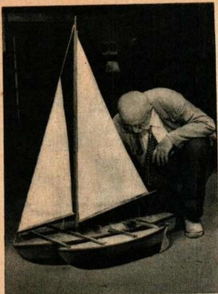
Avant de construire le tripont en grandeur normale, le docteur Herman construisait un modèle à l'échelle pour faire des essais de comportement en mer de l'embarcation.
