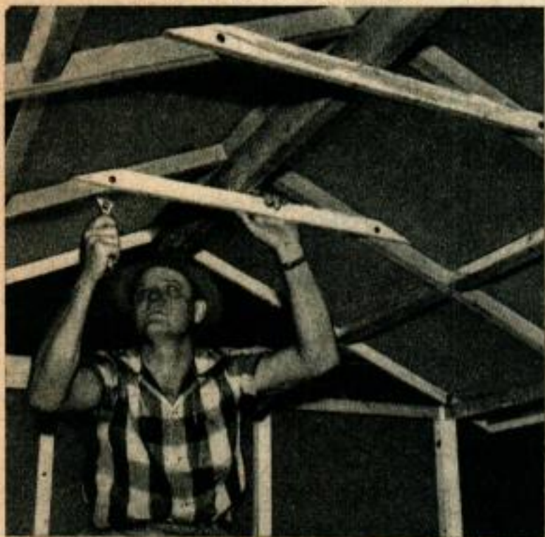
Ci-dessus: deux tirants de 25 \times 50 sont utilisés pour réunir les deux côtés du toit, après que tous les panneaux ont été mis en place. Ci-dessous: Les panneaux du toit sont fixés individuellement sur la panne faîtière avec des vis à bois et des pattes de fixation en fer plat légèrement repliées.
