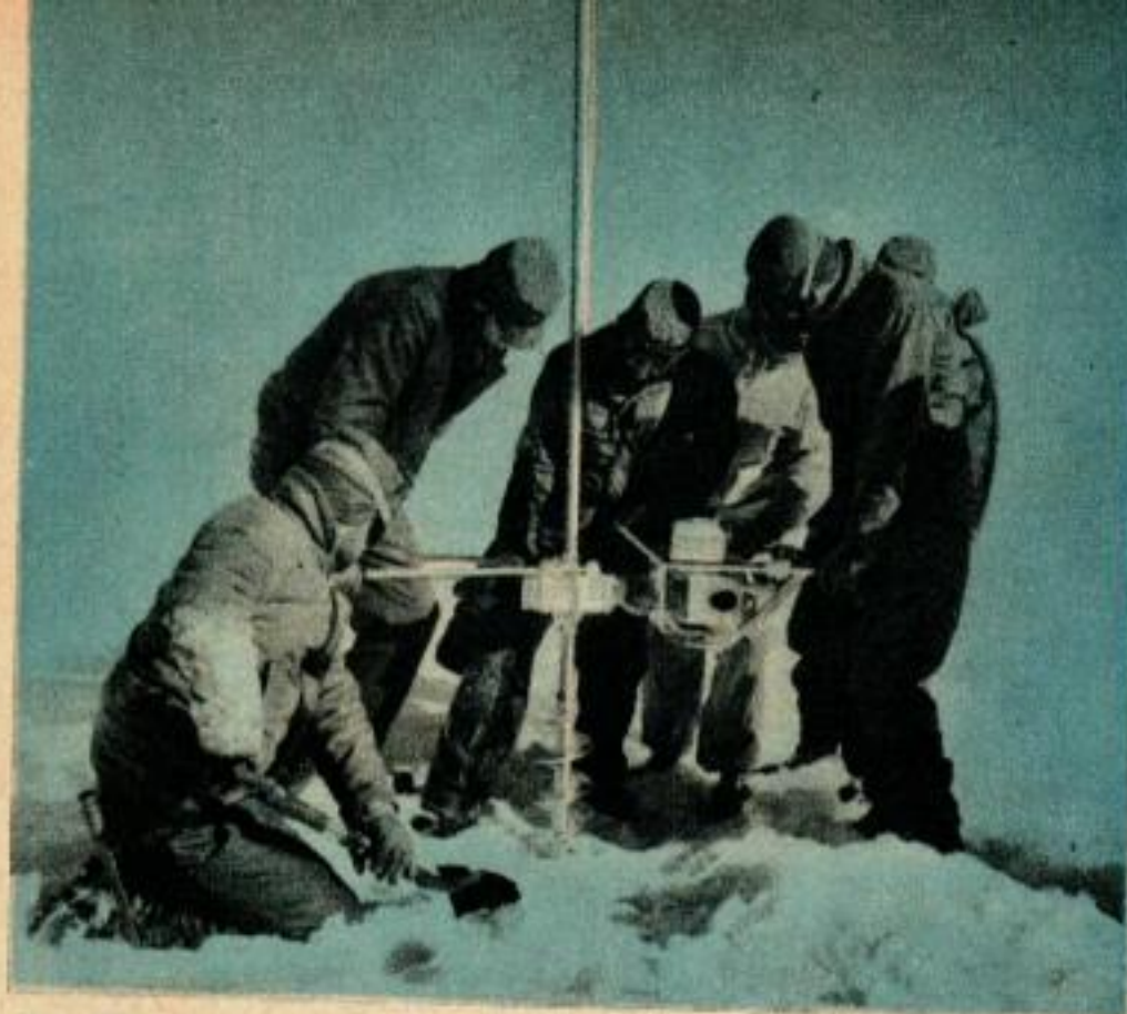
Les «Seabees» déterminent l'épaisseur de la glace avec une foreuse de 6 Mue par un moteur pour s'assurer que la couche pourra supporter de lourds véhicules. Ci-dessous, le brise-glace américain Glacier découpe un canal de 60 km dans la glace de la baie, épaisse de 4,50 m, pour que les navires puissent venir plus près du camp, afin d'être déchargés. La proue d'un navire est poussée au-dessus de la glace pour la briser par son poids.
