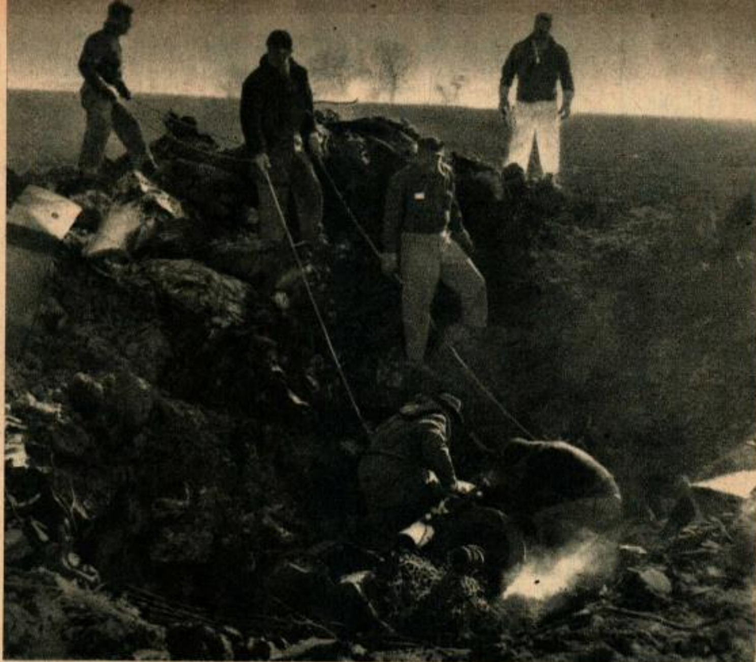
Investigateurs au travail sur un moteur qui brûle encore. Les hommes sont attachés à des cordes de sauvetage, car un réservoir plein d'essence est encore enterré près du moteur.
