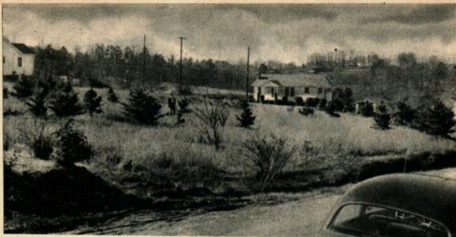
Les déblais retirés de l'excavation du sous-sol servent à remblayer le terrain pour élever le côté en contre-bas de ce terrain au-dessus du niveau de la rue.
