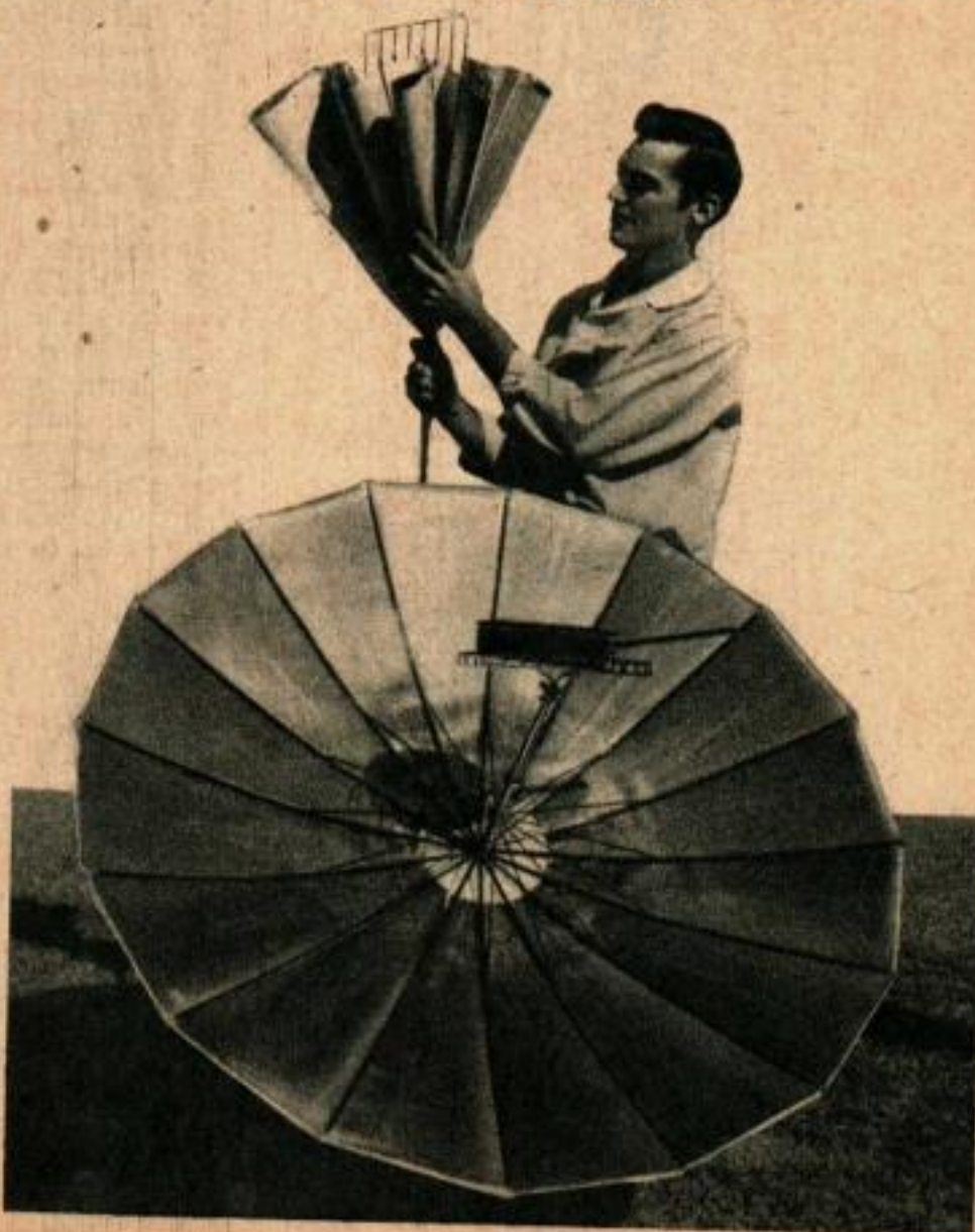
Ci-dessous: Pour les pique-niques, une « cuisinière » solaire portable qui se replie comme un parapluie. Le tissu aluminium concentre les rayons solaires sur un gril.
