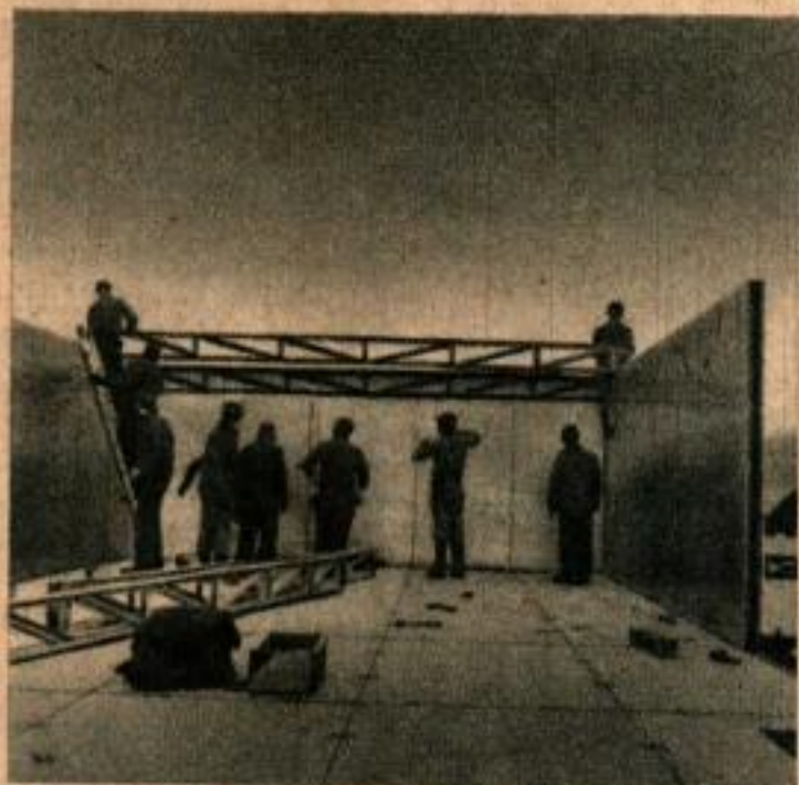
Emboîtant et verrouillant les pièces les unes sur les autres, les équipes du Génie Maritime construisirent un bâtiment de 7,30 m sur 14,60 m chaque jour.
