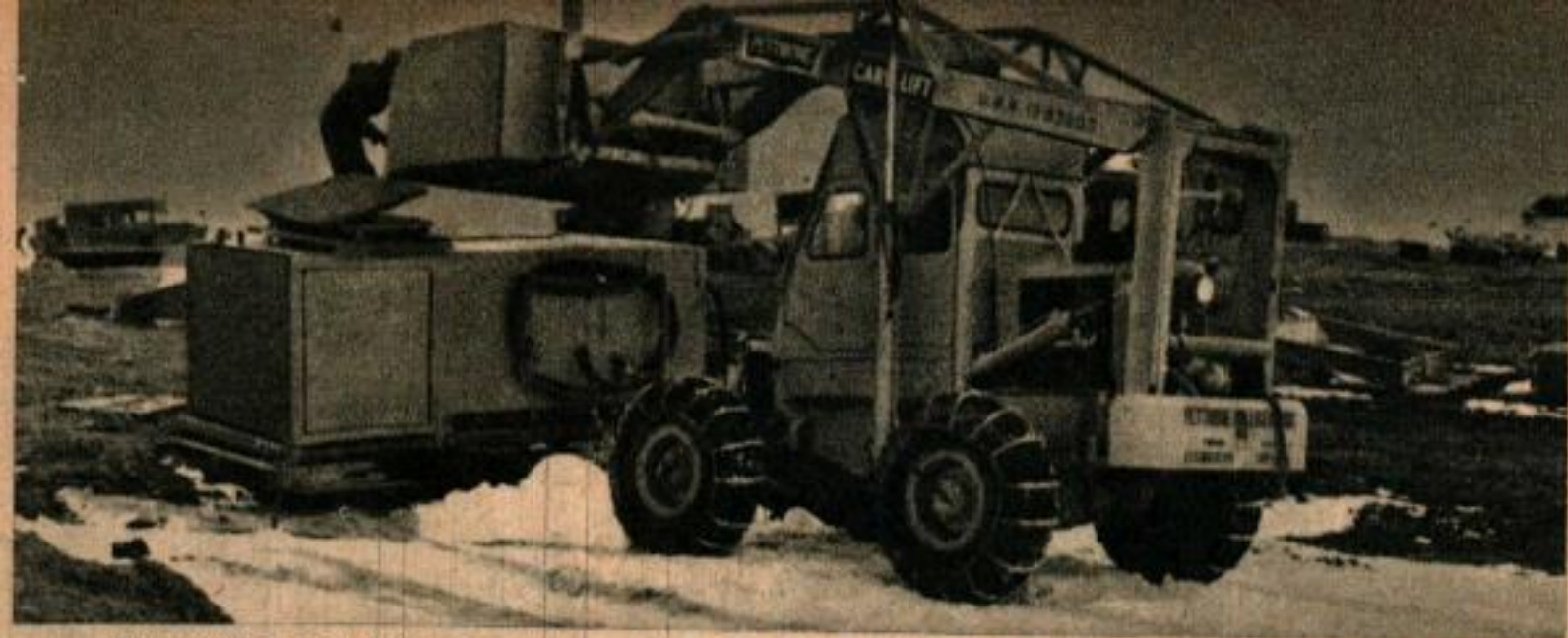
L'appareil de fonte de la neige, ci-dessus à gauche, débite 4 000 litres d'eau potable à l'heure, provenant de quatre «pelletées» de neige propre.
