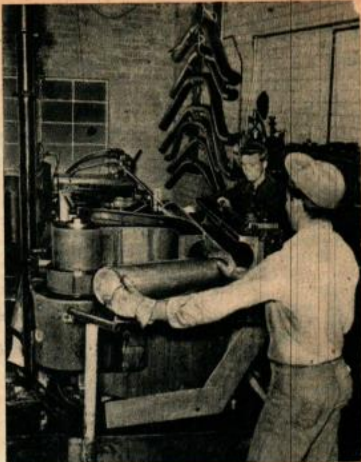
On peut voir ci-dessus, derrière la presse qui les fabrique, toute une série de tubes d'irrigation de formes différentes.
