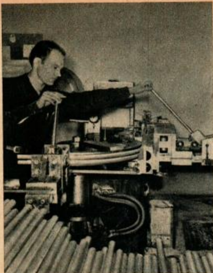
Les tubes de petit diamètre que l'on utilise pour irriguer un seul sillon sont courbés par deux à la fois dans des presses hydrauliques.
