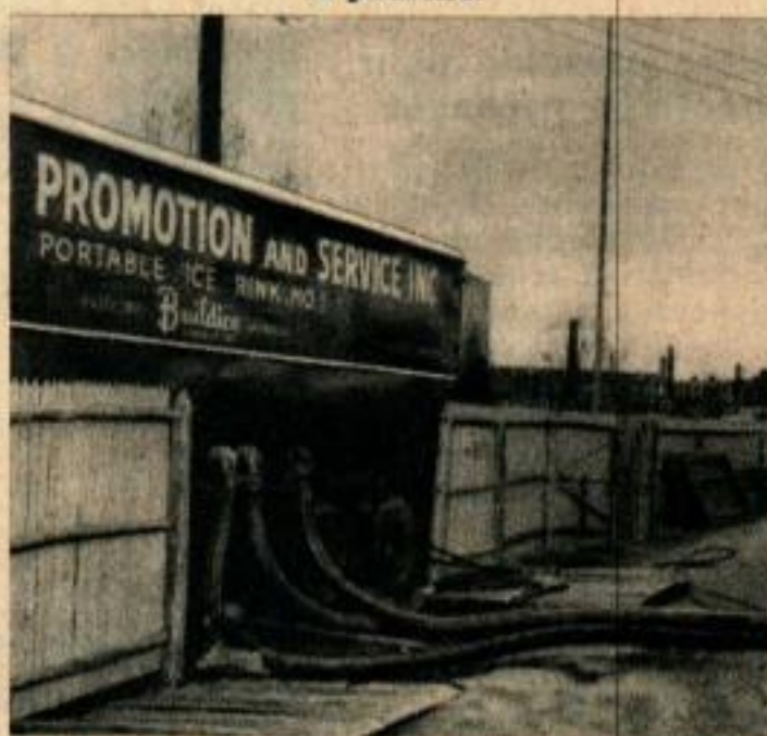
Ci-dessus: un camion transporte les quatre compresseurs refroidissant les 140 tonnes de fluide réfrigérant nécessaires à la piste de 26 x 56 m. Ci-dessous: les tubes sont recouverts de sciure de bois, puis de l'eau est pulvérisée jusqu'à formation d'une couche de glace de 10 cm environ.
