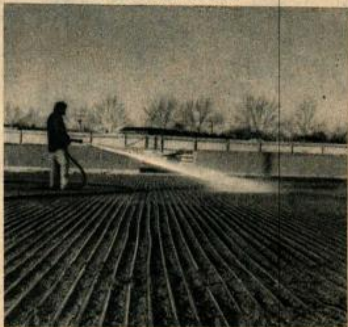
Ci-dessus: un camion transporte les quatre compresseurs refroidissant les 140 tonnes de fluide réfrigérant nécessaires à la piste de 26 x 56 m. Ci-dessous: les tubes sont recouverts de sciure de bois, puis de l'eau est pulvérisée jusqu'à formation d'une couche de glace de 10 cm environ.
