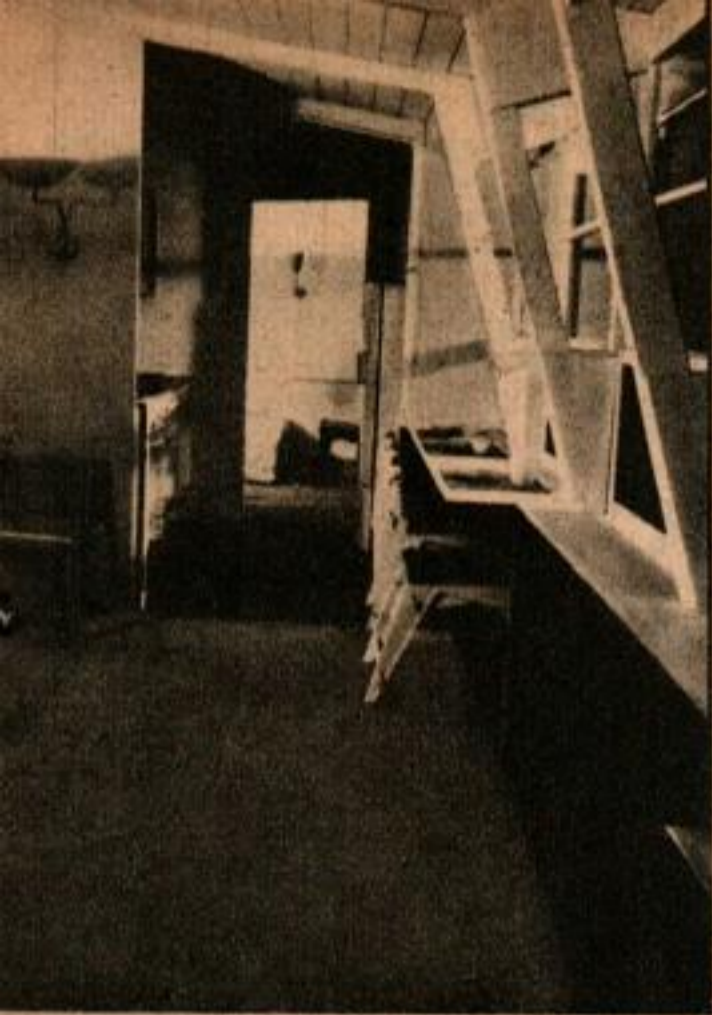
À droite, le constructeur monte les fermes du toit après avoir installé l'un des murs extrêmes et posé une cloison intérieure.
