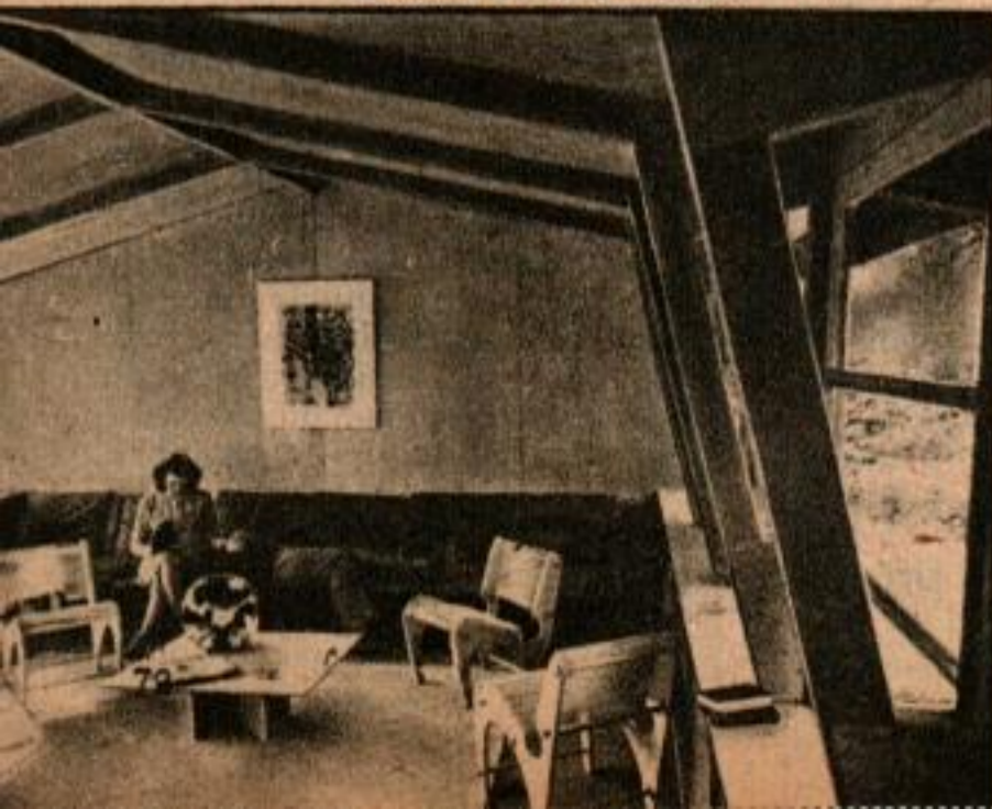
Grande salle commune avec fenêtres des deux côtés. Placards sous les fenêtres. Remarquez le nouveau système de la charpente.
