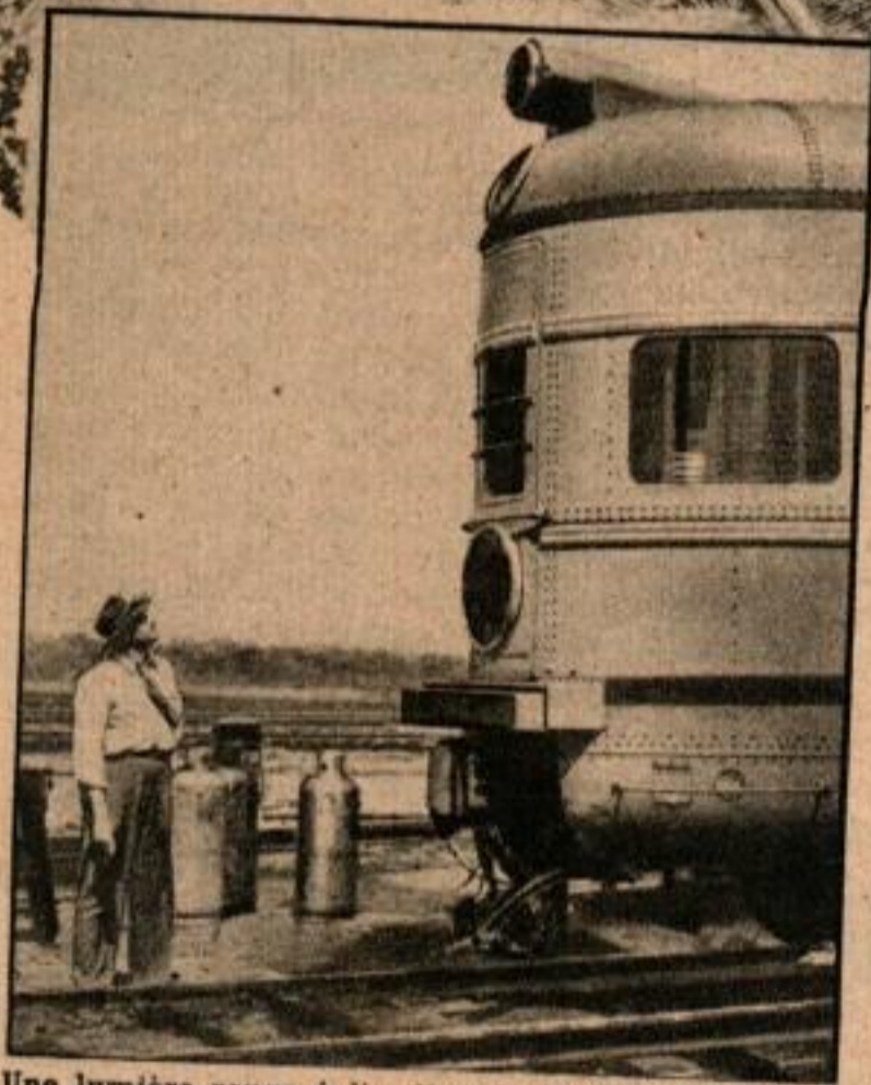
Une lumière rouge à l'arrière de la dernière voiture indique au train qui suit si les freins fonctionnent.
