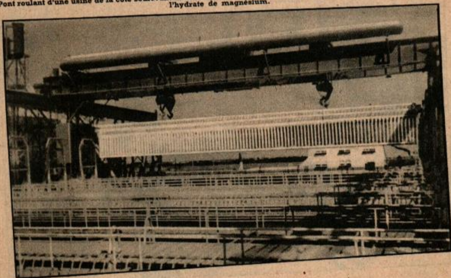
Pont roulant d'une usine de la côte soulevant un élément de filtre, afin d'enlever au moyen d'un jet d'air comprimé l'hydrate de magnésium.
