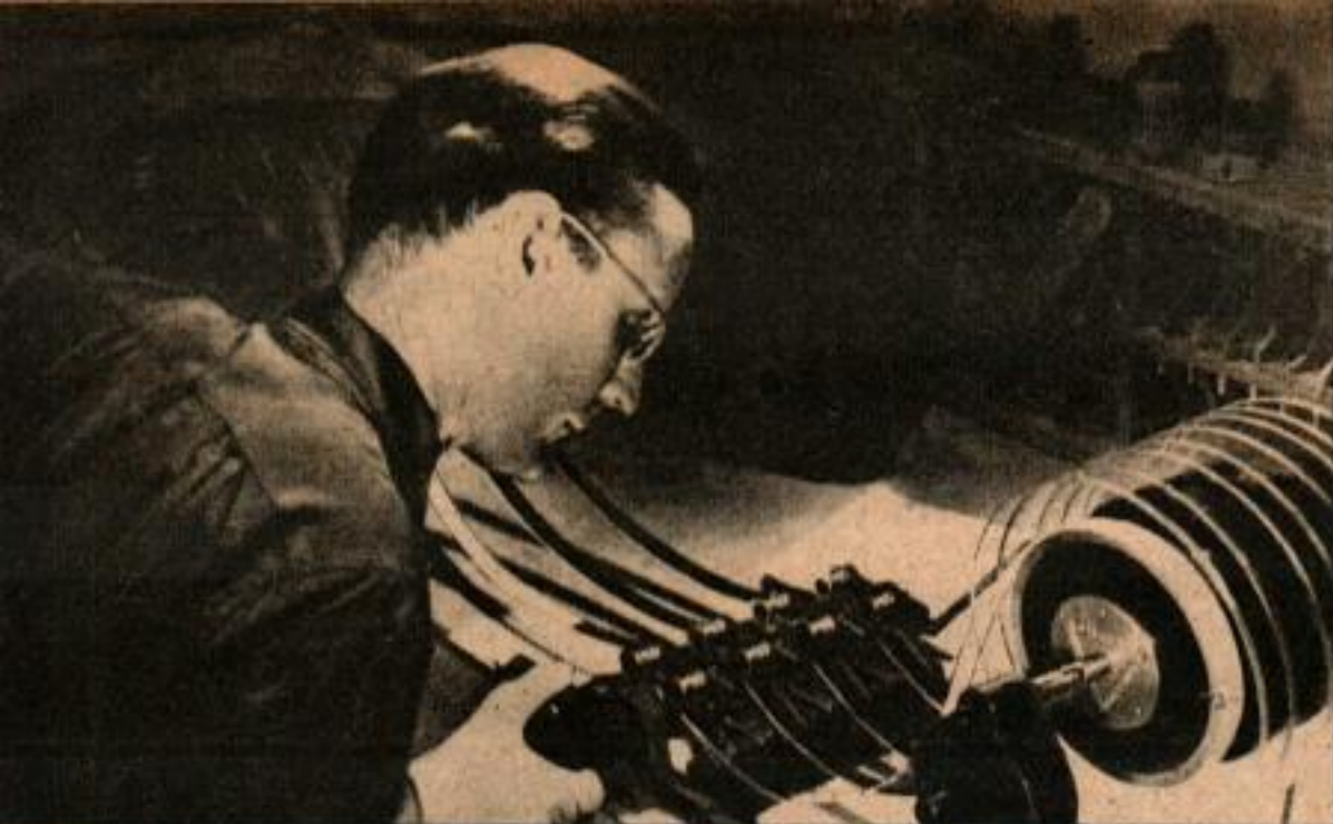
La première opération quand on fait la copie originale d'un film sonore de 16 mm consiste à réunir et à synchroniser des bobines d'images avec trois bobines de piste sonore.
