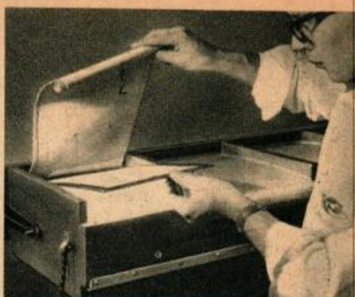
Une épreuve de 203 \times 254 sur papier ordinaire sèche en 8 à 10 minutes. Des doublures en métal ou en amiante protègent le bois du séchoir contre la chaleur.
