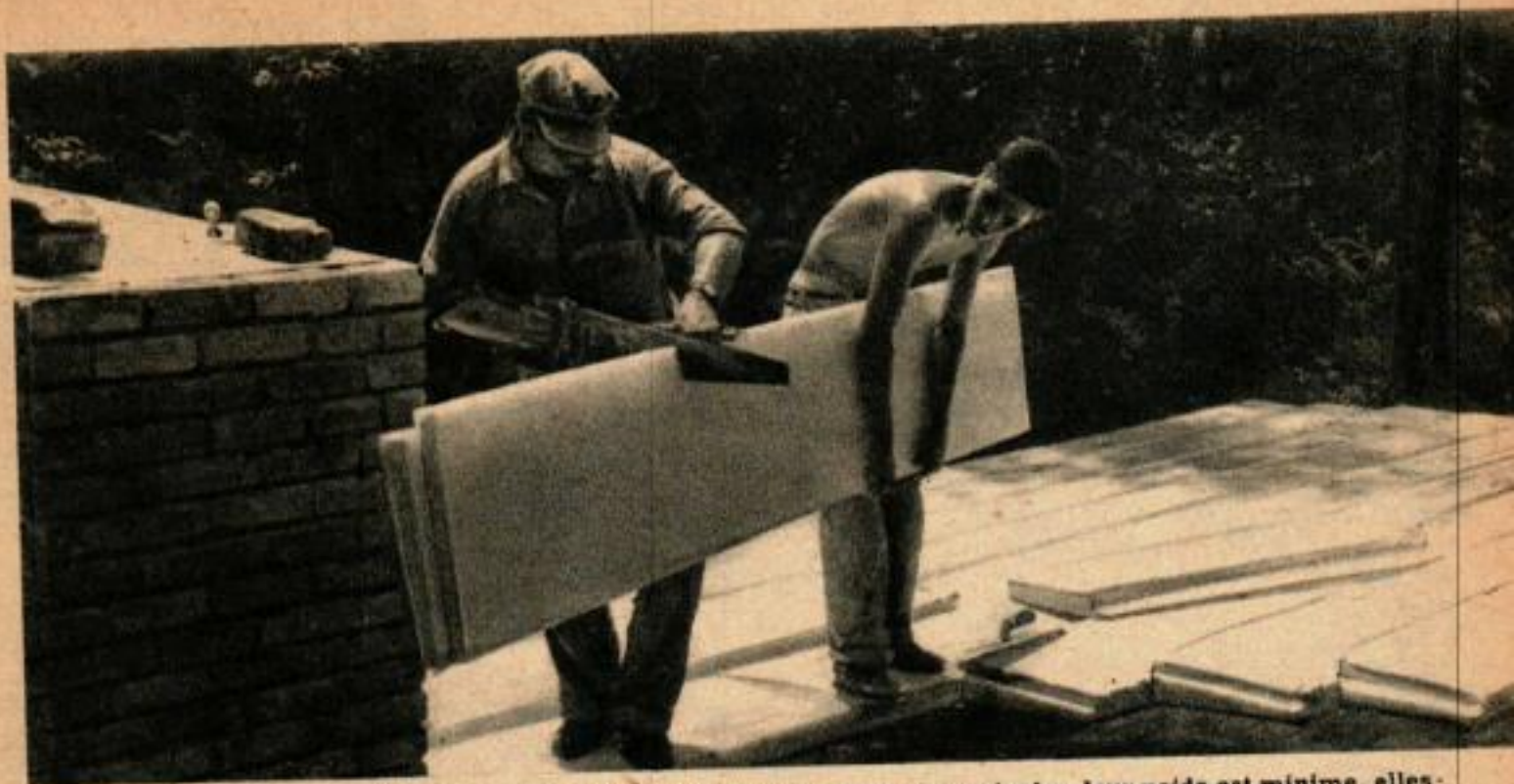
Bien que d'énormes dimensions, les ardoises en Styrofoam sont faciles à manipuler, leur poids est minime, elles peuvent être sciées facilement et même coupées au couteau.
