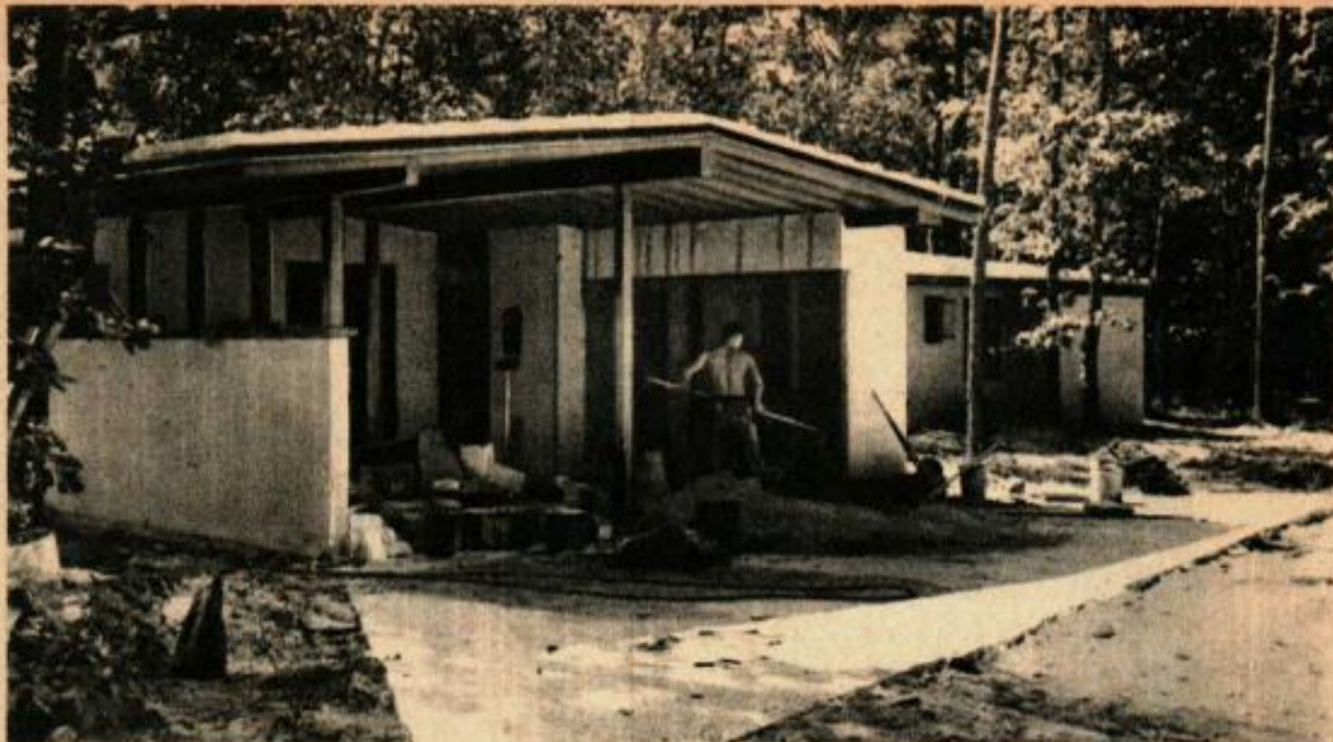
Presque terminée, la maison en écume plastique aura, de l'extérieur, un aspect normal avec son crépissage au ciment.
