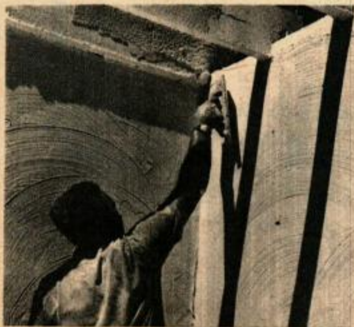
Le constructeur tient sur ses bras 10 m. de panneaux qui ne pèsent que 9 kg. Ci-dessous: l'intérieur des murs en matière plastique est recouvert d'une épaisseur de plâtre de 25 mm.
