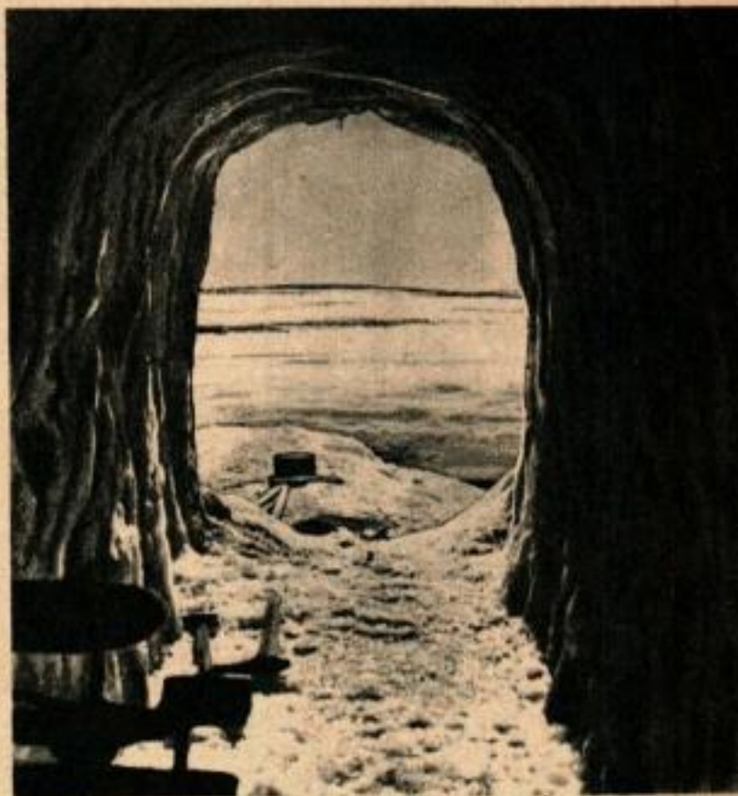
Ce tunnel expérimental est trop petit pour les véhicules. Un tunnel plus grand doit être creusé avec une machine à galerie de mine à avancement continu. Ci-dessous: un rouleau compresseur ordinaire tasse la neige à la surface de la calotte glaciaire, pour construire un terrain d'atterrissage.
