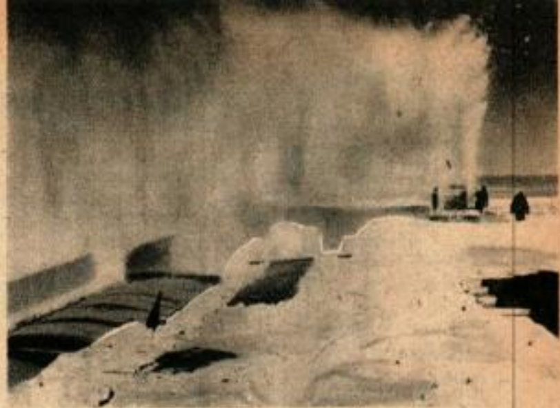
Un chasse-neige mécanique marche le long de la tranchée après la pose des formes, et les recouvre de neige.
