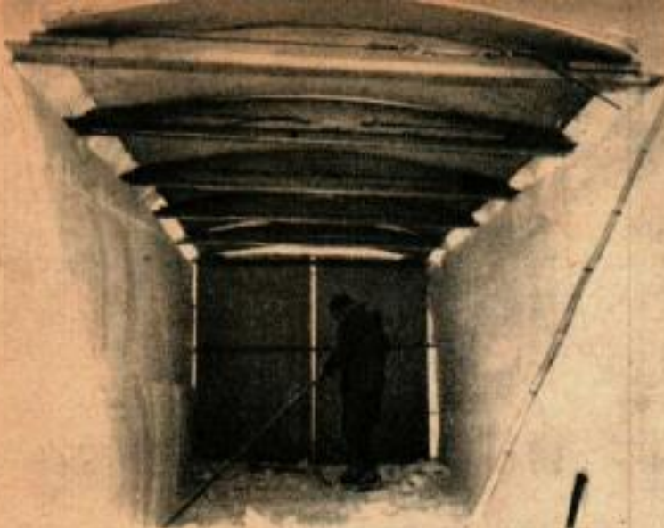
Les coffrages démontables en contreplaqué, en forme d'arcs sont mis en place sur la tranchée, à 6) centimètres du bord supérieur. La neige sera «soufflée» par-dessus.
