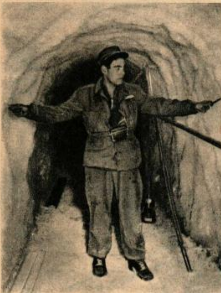
Ce tunnel expérimental percé dans la glace, sur le bord de la calotte glaciaire, est large de 1,20 m. Il a été creusé à la main avec des pics.
