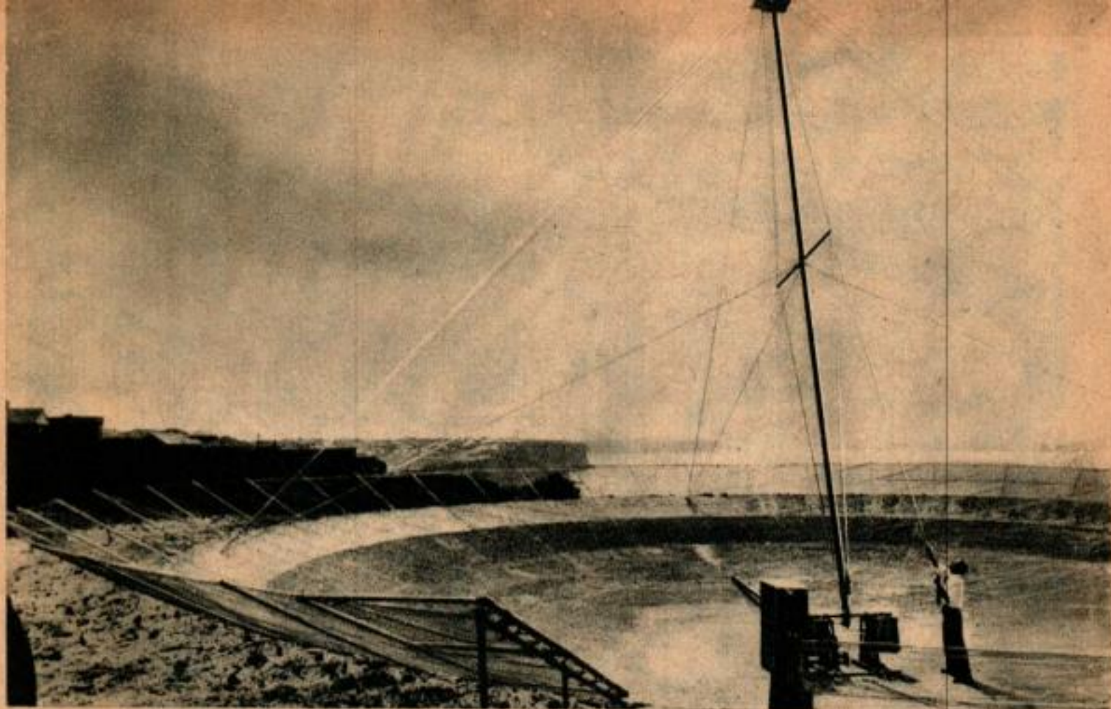
Ce radiotélescope, placé sur une falaise près de l'entrée du port de Sydney, est monté dans une dépression en forme de coupe creusée dans le sol.
