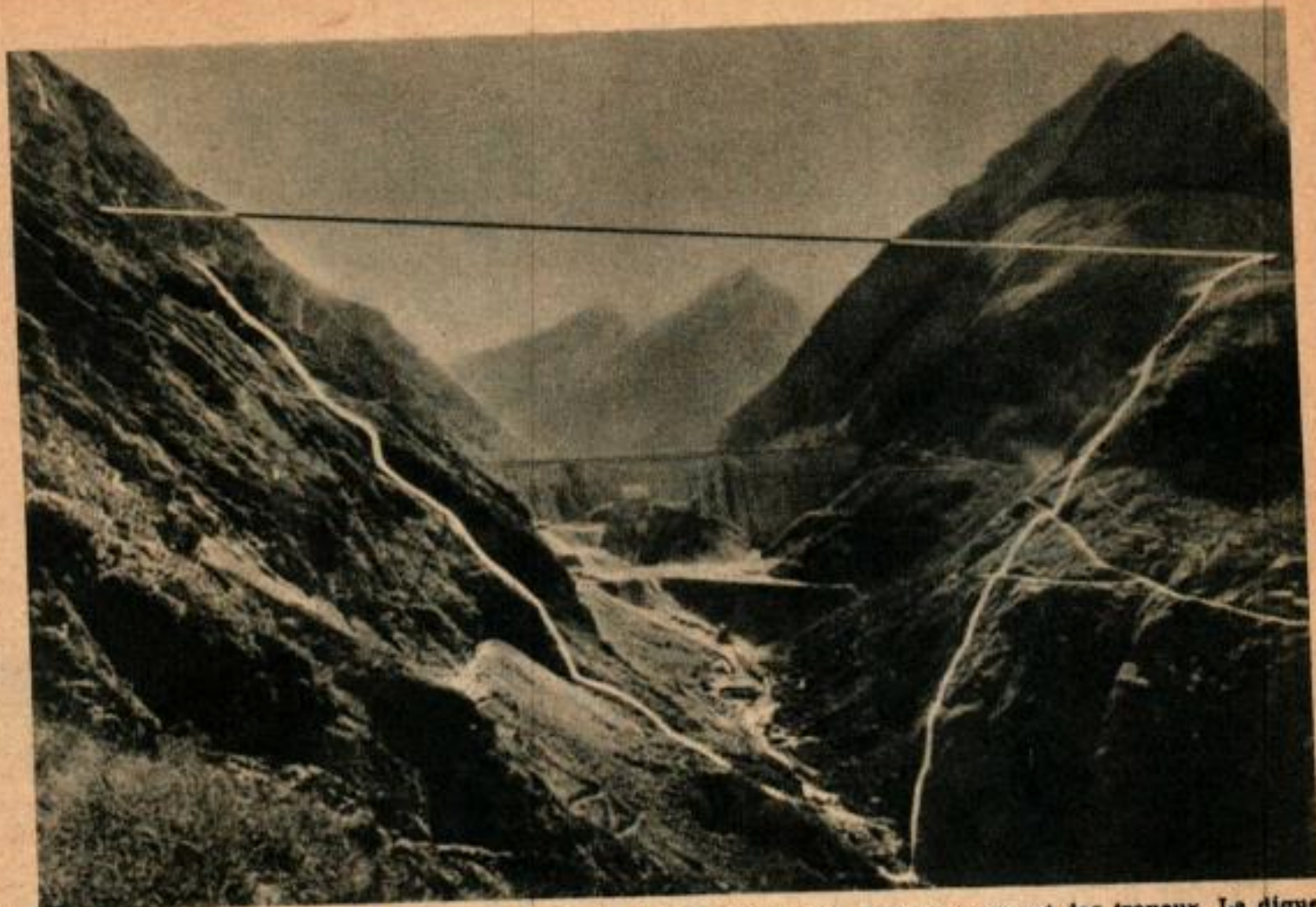
Le tracé du nouveau barrage est indiqué sur cette photo prise avant le commencement des travaux. La digue aura une longueur de près de 800 m en son sommet.
