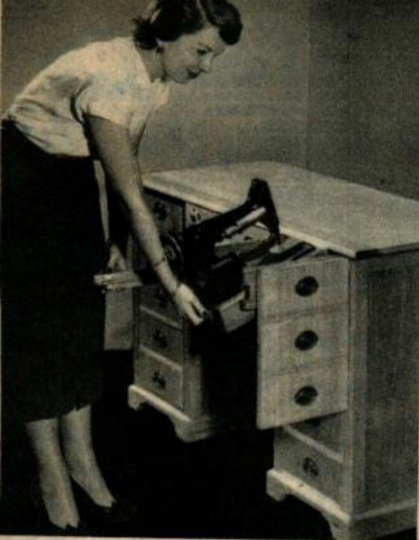
La machine à écrire portable, ainsi que la machine à coudre, sont toutes les deux suspendues dans leurs compartiments respectifs; pour les relever en position de travail, il faut d'abord les tirer pour les engager sur le rail de la porte.
