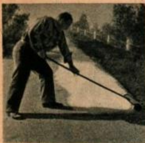
1 Par une chaleur de 32° C. cet ouvrier «verglasse» une côte à 35 % en repandant du savon liquide sur la chaussée.
