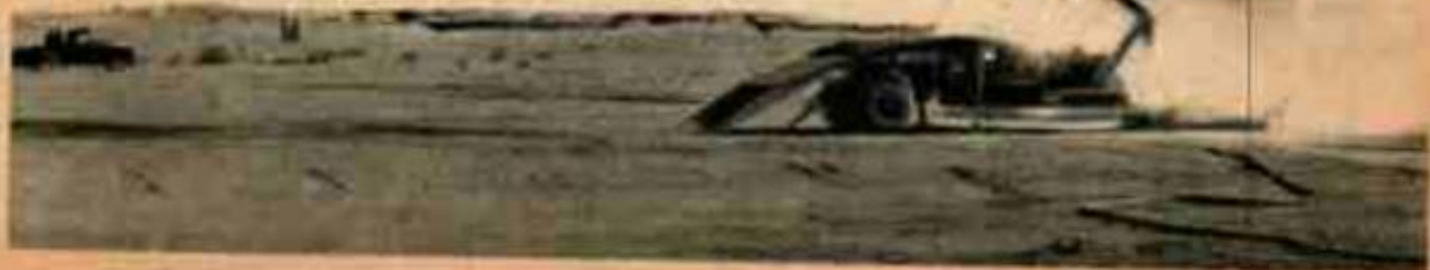
Le Thunderjet Republic F84 est lancé à partir d'une piste-lanceur montée sur un camion. Il utilise une bouteille d'appoint qui lui donne une impulsion supplémentaire.
