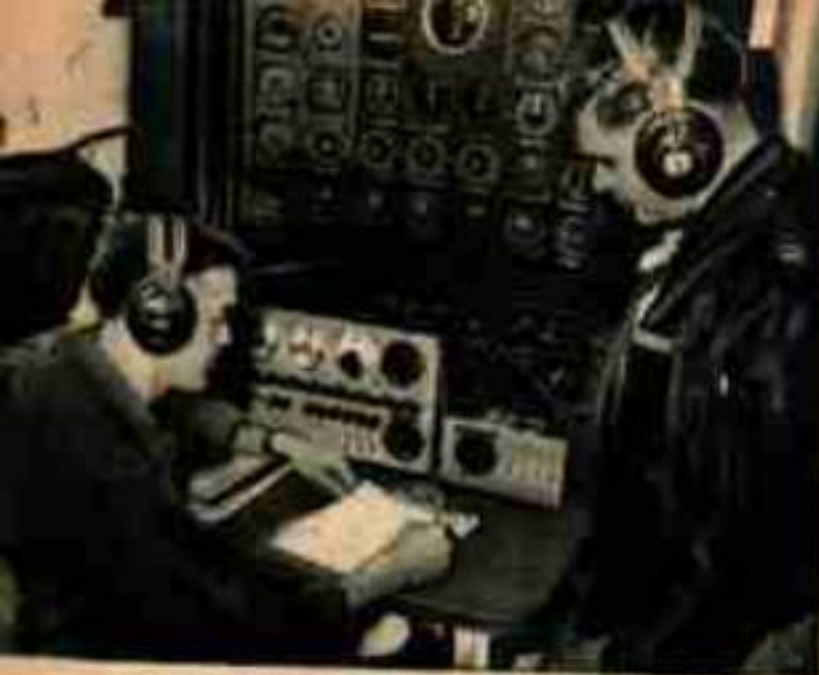
Au cours des épreuves d'essais du Gloemaster C-124C un ingénieur d'études enregistre les lectures des instruments avec l'œil attentif du pilote d'essais.
