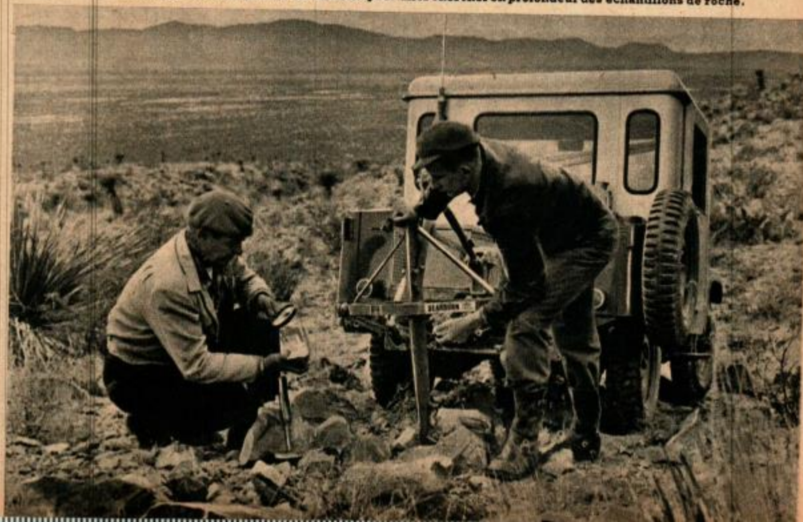
Sur la seconde Jeep se trouve un soc de charrue qui sert à faire venir en surface des échantillons de roches. Les prospecteurs utilisent une foreuse à pointes de diamant pour aller chercher en profondeur des échantillons de roche.
