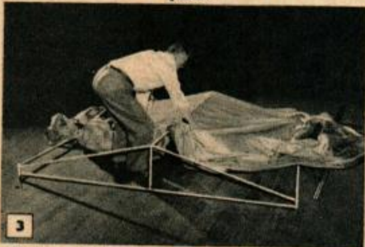
3 Ci-dessus, le deuxième temps du montage consiste à placer le toit et les côtés grillagés sur la charpente. Ci-dessous montage des piliers d'angle après mise en place du toit et des côtés.
