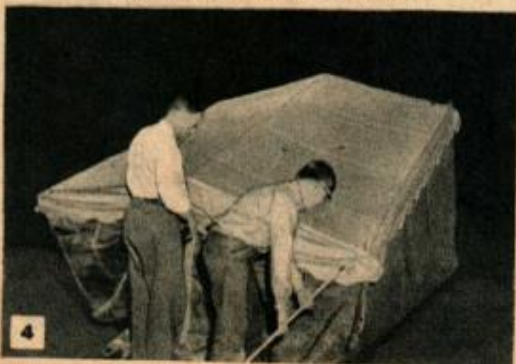
3 Ci-dessus, le deuxième temps du montage consiste à placer le toit et les côtés grillagés sur la charpente. Ci-dessous montage des piliers d'angle après mise en place du toit et des côtés.
