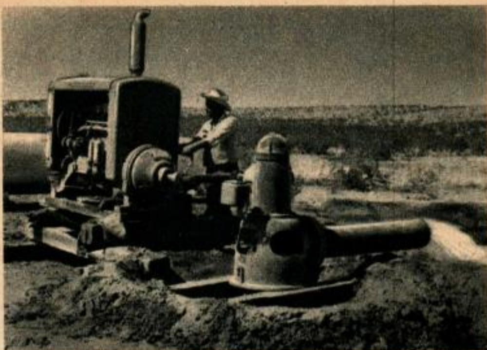
L'eau est débitée par des pompes à moteur à raison de 9,5 m 3 /mn (2 500 gallons).
