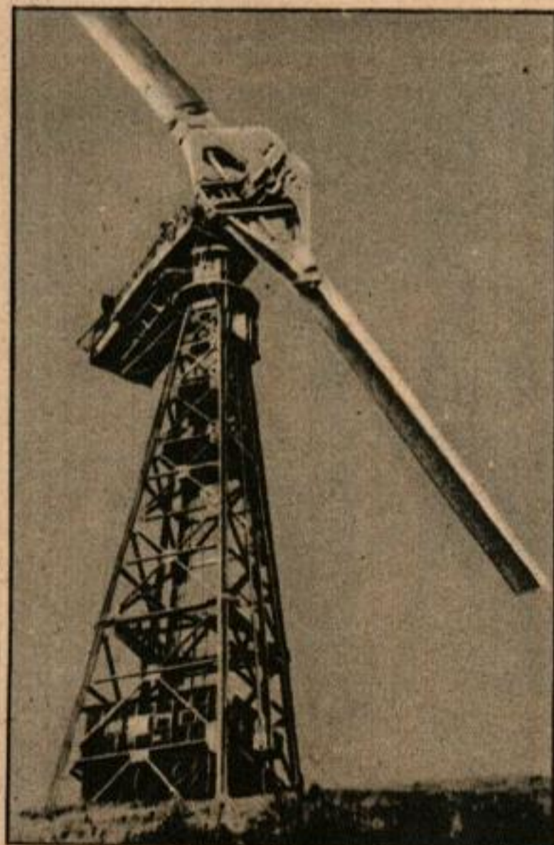
L'armée a envisagé l'emploi des génératrices à vent de 100 kilowatts (ci-dessus) pour fournir le courant à ses bases d'outre-mer. La première génératrice pratiquement utilisée a été construite en 1941 sur un pylône de 30 m (ci-dessous) dans les collines du Vermont. Ses pales ont 20 mètres de long.
