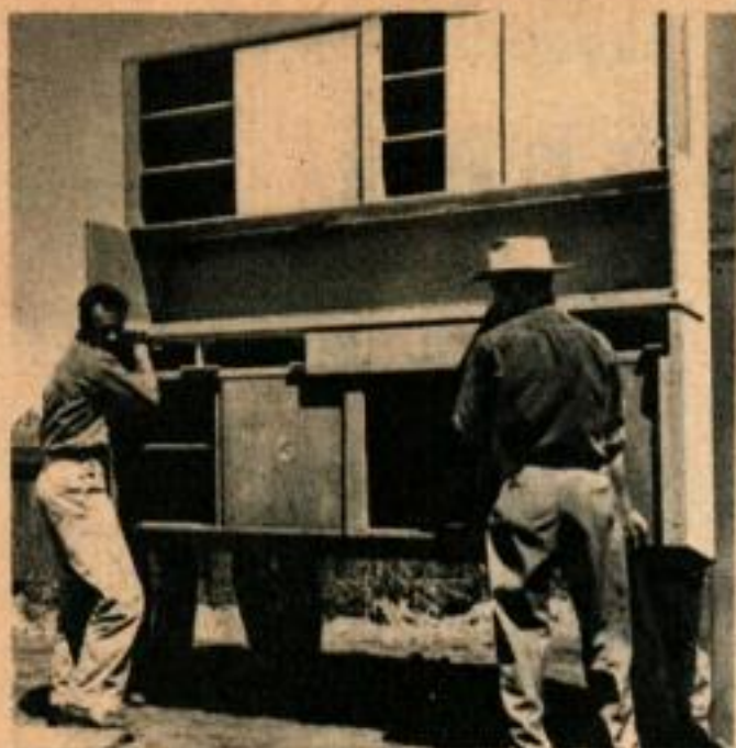
On met en place la cloison en bois dur préfabriquée d'un placard de cuisine.
