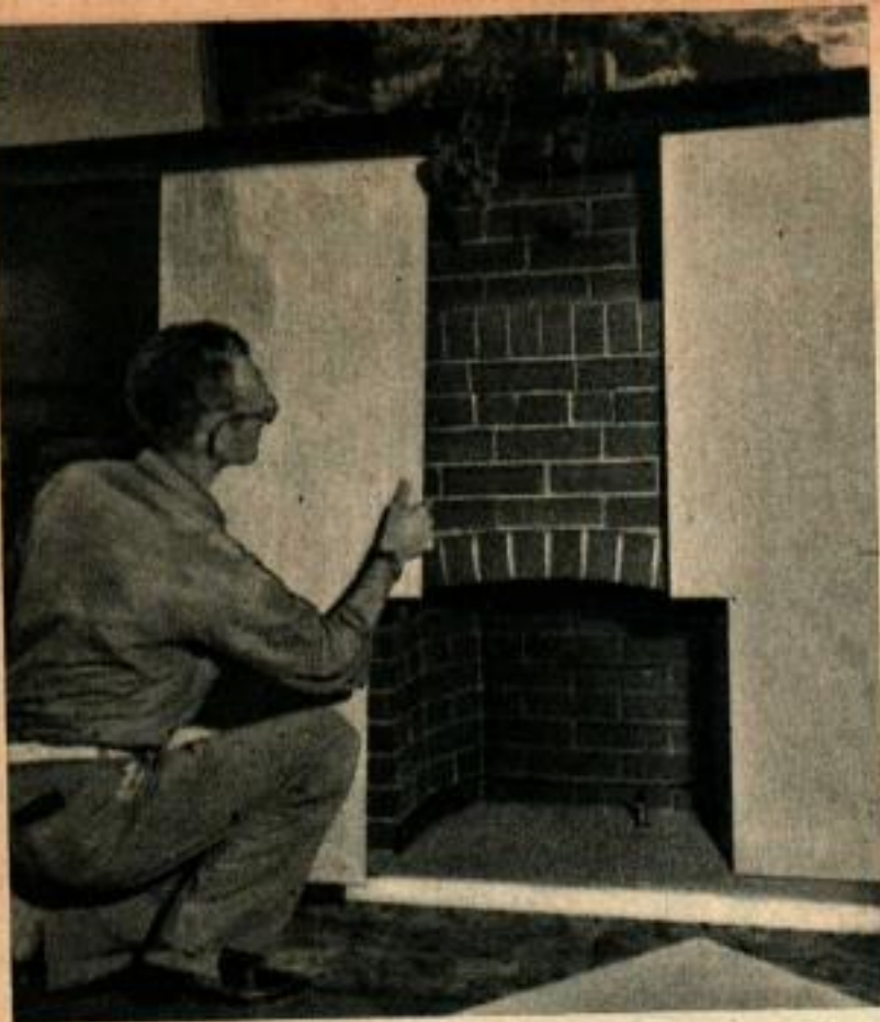
Ci-dessus, essayer chacun des panneaux pour s'assurer qu'il joint bien avec les panneaux voisins.
