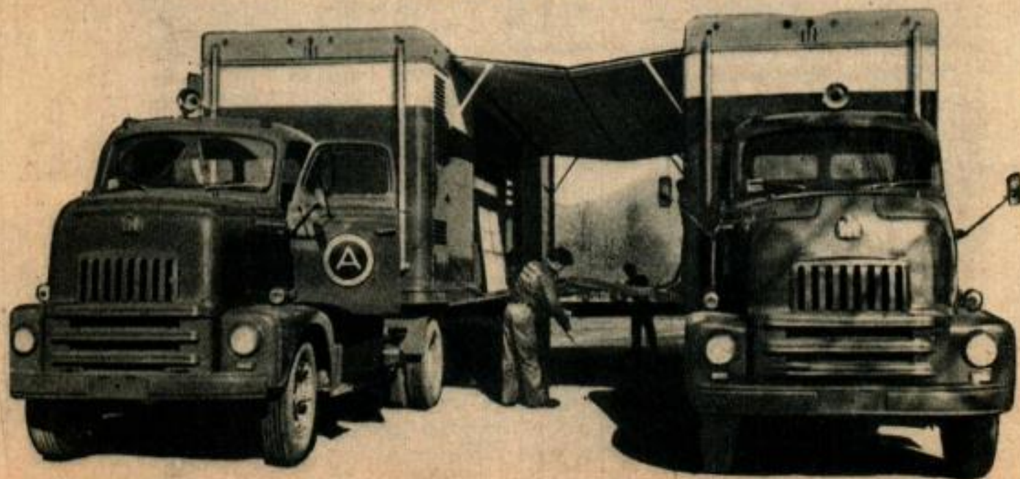
En garant deux camions poids lourds l'un à côté de l'autre, chacun étant doté de parois dépliantes, et en les accouplant de la manière montrée ci-dessous, cette société transporte son propre auditorium mobile qui lui permet de mettre des sièges à la disposition de cent personnes pour les réunions.
