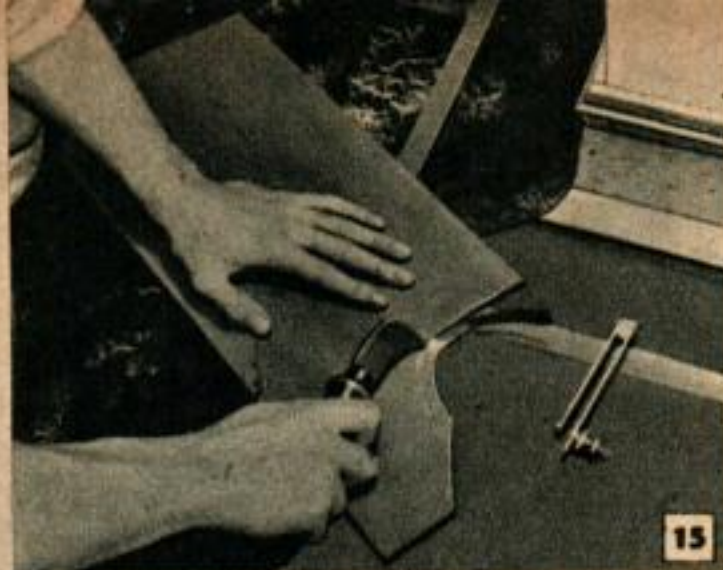
Ci-dessus, coupe à 45° pour donner l'onglet sur l'épaisseur du panneau de linoléum se posant sur un angle extérieur.
