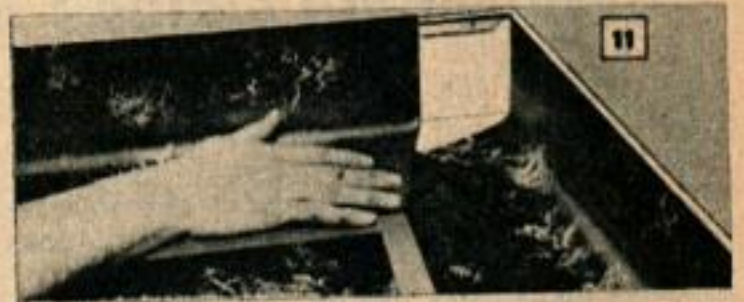
Les figures 11 et 12 montrent la façon de faire un raccord à angle vif n'utilisant pas les raccords rapportés arrondis en métal ou en matière plastique.
