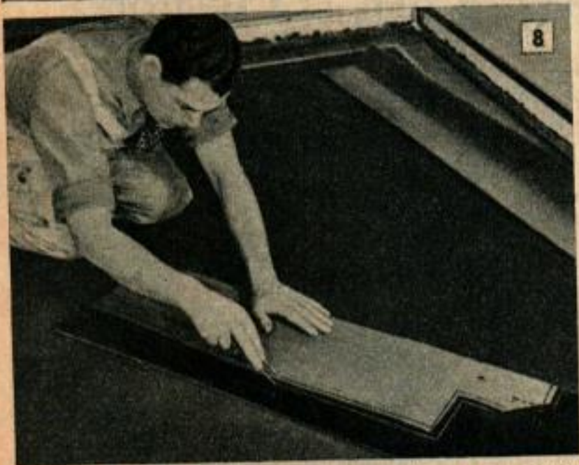
Ci-dessus, lorsqu'on utilise des patrons pour couper le linoléum servant de plinthe, tenir compte de la largeur nécessaire pour placer le linoléum sous la moulure et contre les raccords rapportés des angles de la pièce.
