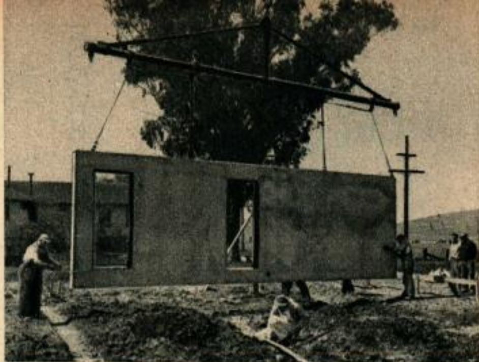
Des ouvriers s'apprêtent à guider une section de mur faite d'une seule pièce pour la mettre en place. Le mur est épais de 15 cm (6 in.) et fabriqué en béton armé léger. Les cadres des portes et des fenêtres sont encastés à même le mur compact.
