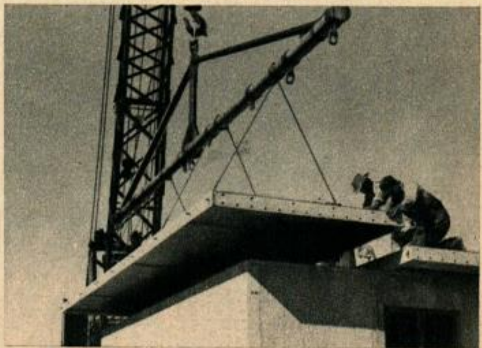
Ci-dessus, soudure d'un gousset d'assemblage à la partie supérieure des murs. Les murs sont également soudés à des plaques de fondation, en acier, maintenues par des assises du type «à pierres perdues». Ci-dessous, une grue laisse descendre un des panneaux du toit; deux ouvriers le mettent en place. Ces panneaux de toiture sont épais de 15 cm (6 in.); ils sont soudés aux murs et entre eux de façon à obtenir une construction robuste.
