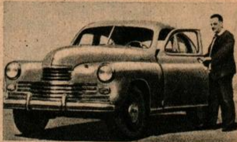
La voiture "Victoire", une quatre cylindres, suit les tendances générales de la fabrication américaine. Les phares encastrés dans de longues ailes profilées.
