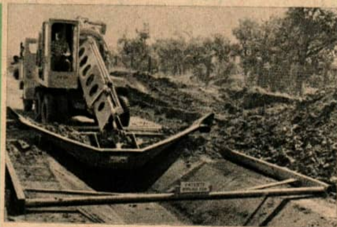
La poutrelle de force de la machine que l'on voit à gauche pousse vers l'avant une énorme pelleteuse qui est maintenue à l'alignement par des patins en acier, puis la ramène en arrière, la forçant à mordre dans le sol à la profondeur correcte. La machine laisse derrière elle un canal aux parois très lisses.
