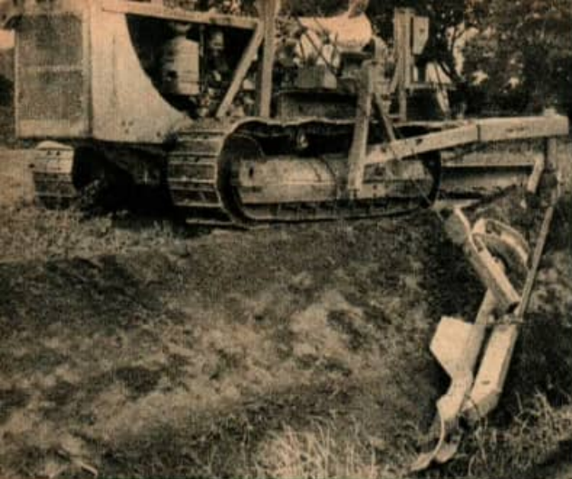
La lame d'acier de cette machine à rectifier les pentes, ci-dessus, sert à nettoyer et à remettre en forme les parois latérales d'un canal. La terre est tirée sur le bord de celui-ci et un soc incliné l'épand à l'arrière du tracteur.
